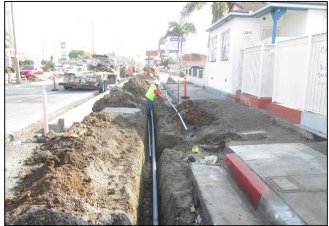
Uplight Conduit Installation
