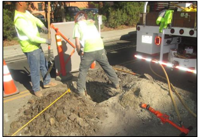
Belco Pot Holing Sta 84+00
